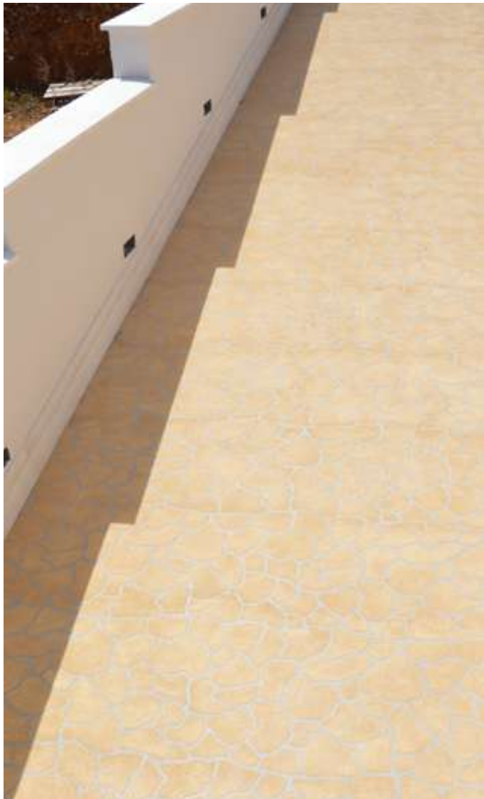
Villa privata - Cagliari (CA) PLAM SPRAY Sasso Irregolare / 5 mm. Private villa - Cagliari, Italy PLAM SPRAY Sasso Irregolare / 5 mm.
